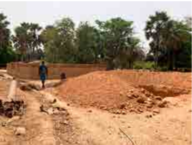
Cbantier d’une maison d’bôtes en bauge. Photo par Nzinga B. Mboup. Casamance, 2021 Building site for a traditional cob guest bouse. Photo by Nzinga B. Mboup. Casamance, 2021
