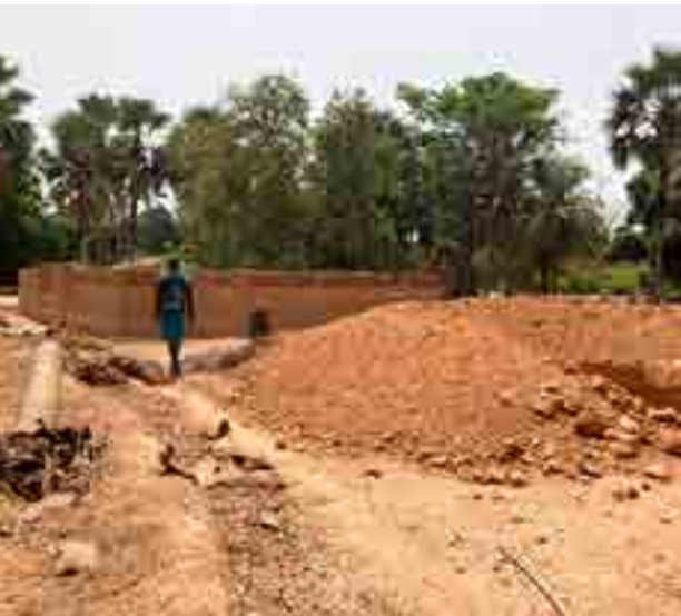
Cbantier d'une maison d'hôtes en bauge. Photo par Nzinga B. Mboup. Casamance, 2021
