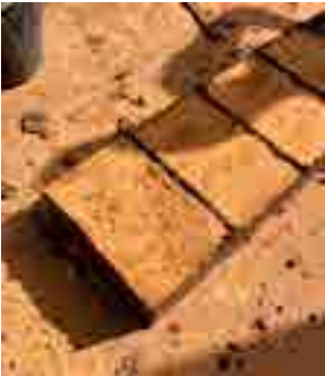
Fabrication d'adobes. Photo par Oumar Sanoko. Sénégal, 2024
